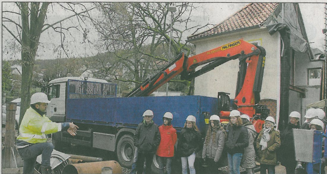
Wasserwerk am Pommernplatz: Hydrogeologe Dr. Stefan Steinmetz (vorn links) erläuterte den Besuchern die Bauarbeiten.
