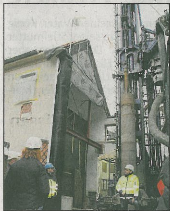
Mitten im Haus: Die Bohranlage, mit der die alten Rohre herausgezogen werden.
